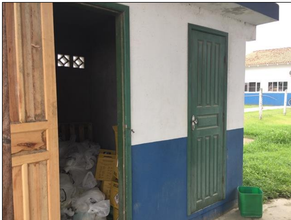
Figura 15 – Armazenamento Externo do Pronto Atendimento Fonte: Premier Engenharia, 2018.
