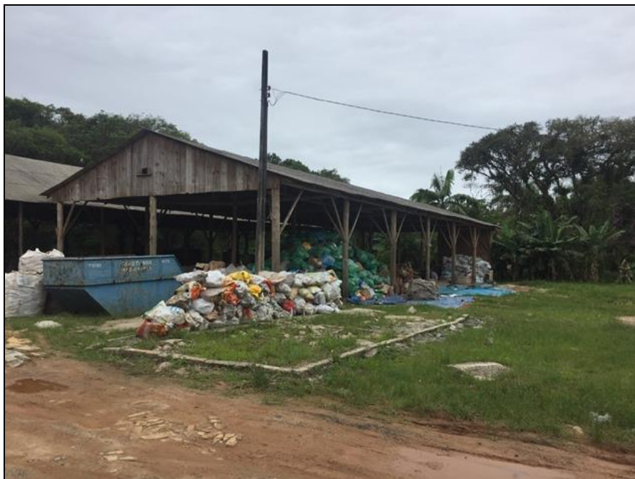
Figura 24 – Unidade de triagem de recicláveis (vista 2) Fonte: Premier Engenharia, 2018.
