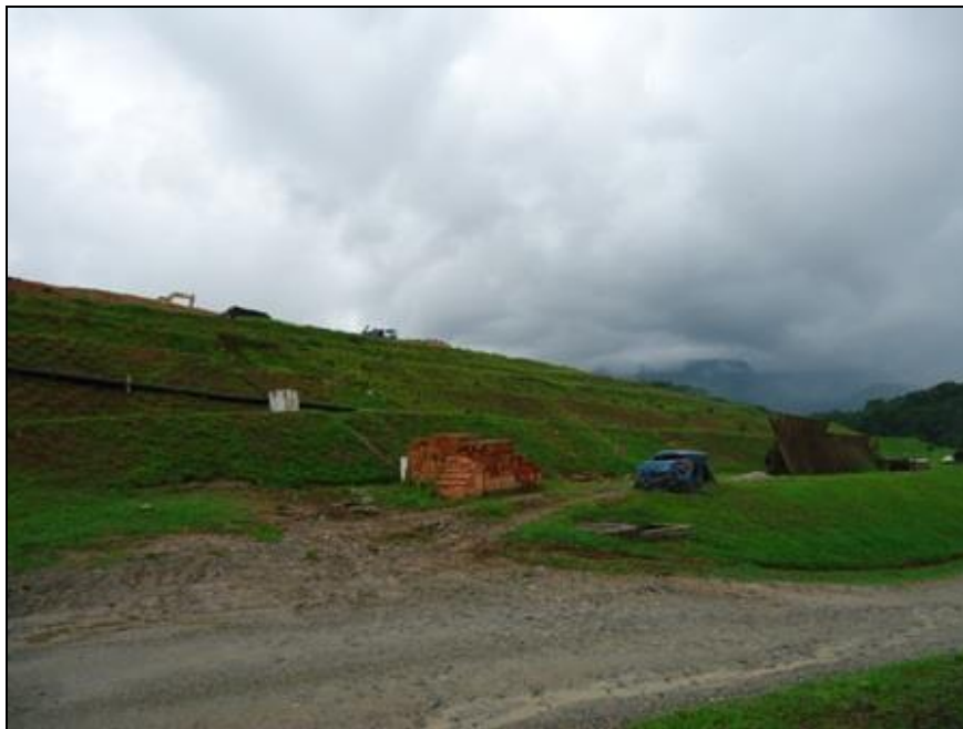
Figura 18 – Vista do aterro de Joinville Fonte: Premier Engenharia, 2018.
